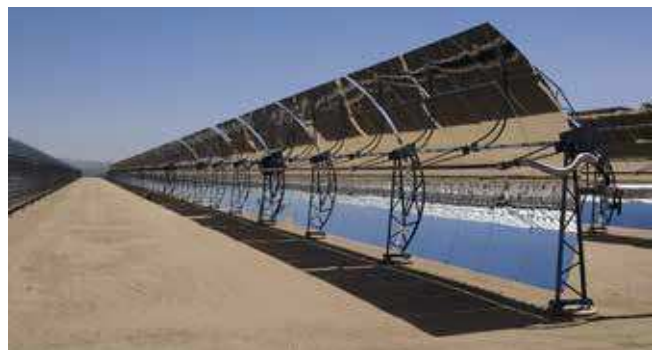
Объект: солнечная электростанция Ouarzazate Месторасположение: Марокко Мощность: 160 МВт
